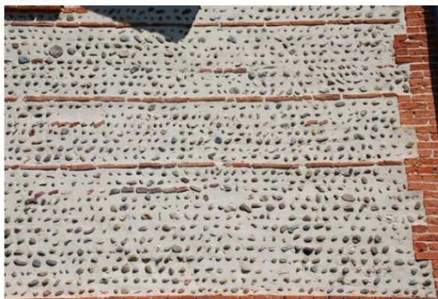
*Cauna: restauration d'un mur de galets. Les galets dépassent peu ce qui constitue une entorse moins importante que lorsque les galets sont complètement détournés. En revanche, le sablage des briques les ont entamé la pellicule dure de protection.*
