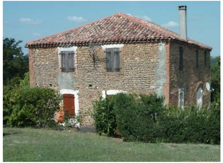
*Lacajunte: maison dont l'enduit de finition a été enlevé, saignées rebouchées au ciment. L'appareillage est fragilisé. Il ne doit pas être rejointoyé au ciment entre les pierres mais être quasiment entièrement recouvert par l'enduit de finition sable/chaux.*
