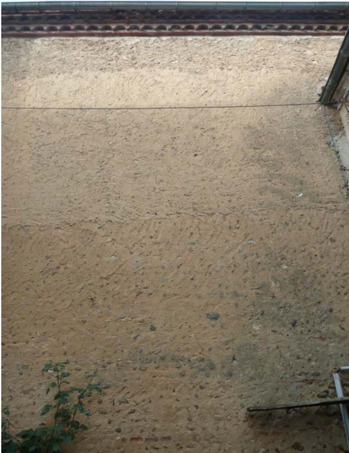
*Urgons: mur enduit traditionnellement: seule la tête des pierre apparaît; le mortier de terre est protégé et l'enduit de finition à la chaux laisse le mur « respirer » (n'emprisonne pas l'humidité dans le mur ou la maison)*
