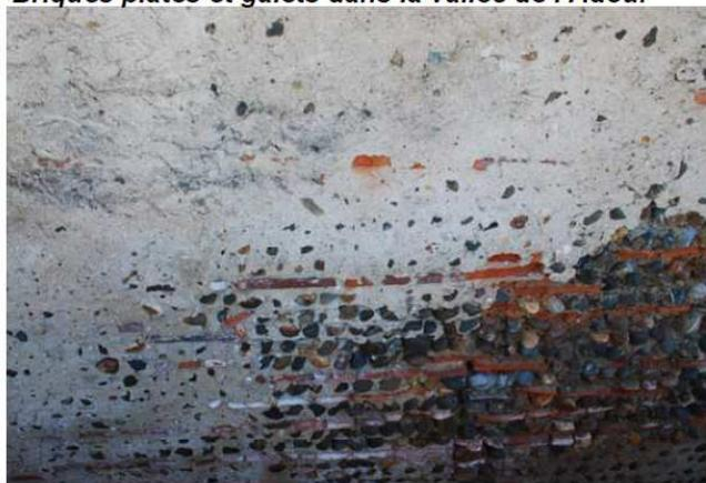
*Cauna: la dégradation de l'enduit de ce vieux mur montre les différentes couches d'enduit traditionnel: les galets ne sont pas visibles, à part les plus saillants. Une couche de finition protège le montage à la terre crue et les briquettes fragiles.*
