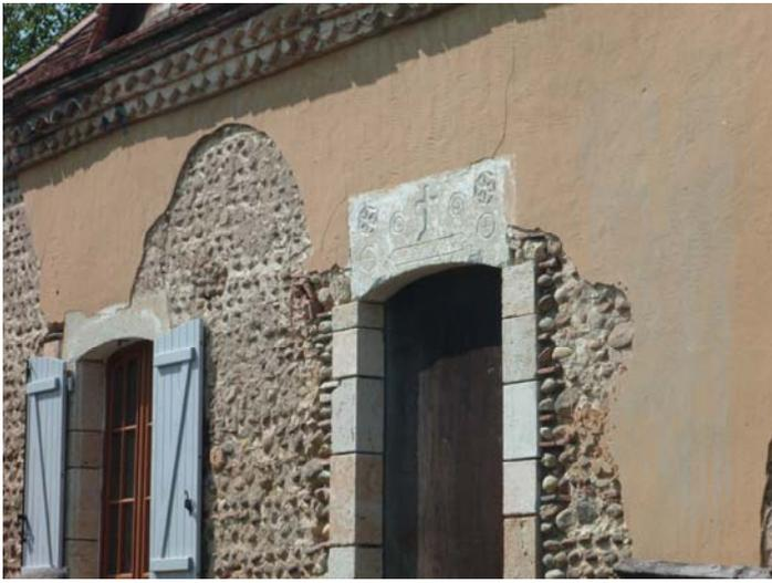
*Lacajunte: l'enduit de finition se dégrade et laisse apparaître l'appareillage de galets et terres cuites liées au mortier de chaux et de terre. On voit que l'enduit est naturellement coloré par le sable, il est très lisse et « mourir » sur les pierres d'encadrement. Les linteaux de pierre calcaire et les encadrements sont protégés par un lait de chaux qui déborde sur l'enduit.*
