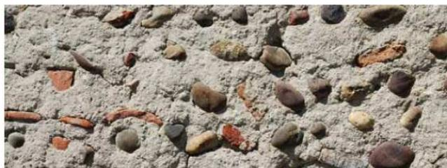
*Montage du mur à la terre et la chaux: ne pas appliquer de ciment qui empêche de respirer le mur et provoque des remontées capillaires: un inconfort humide dans les maisons.*
